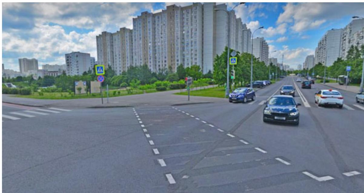
Обратите внимание, на фотографии видны следы традиционной "зебры", которую стерли перед нанесением новой диагональной разметки.
